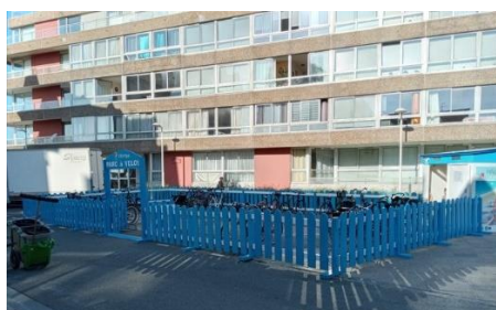
Figure 16 : Clôture d'un parking à vélo fabriqué à partir de bois de palettes non consignées
