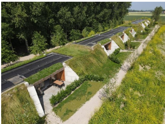
Figure 12 Paardekreek Dikesuites : logements circulaires
