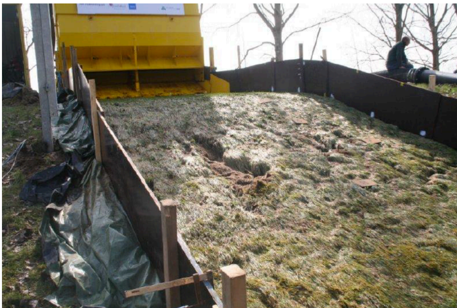
Figuur 60 Overslagproef vechtdijk - Eerste schade (Meer, 2012)
